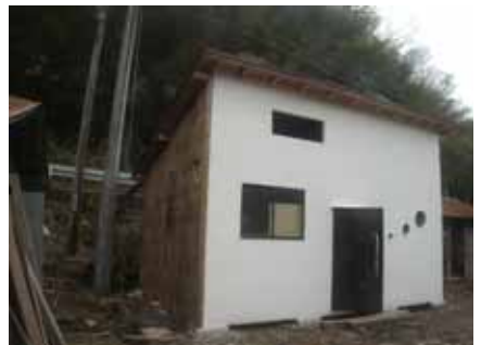
構造部分完成 10/1/29
