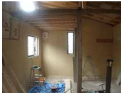
石膏ボード・換気扇 10/2/8
