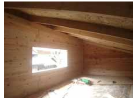
ロフトの壁板張り 10/2/14
