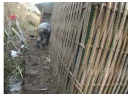
外壁の竹組み 10/1/26
