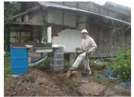
水道管仮埋め立て 10/4/19
