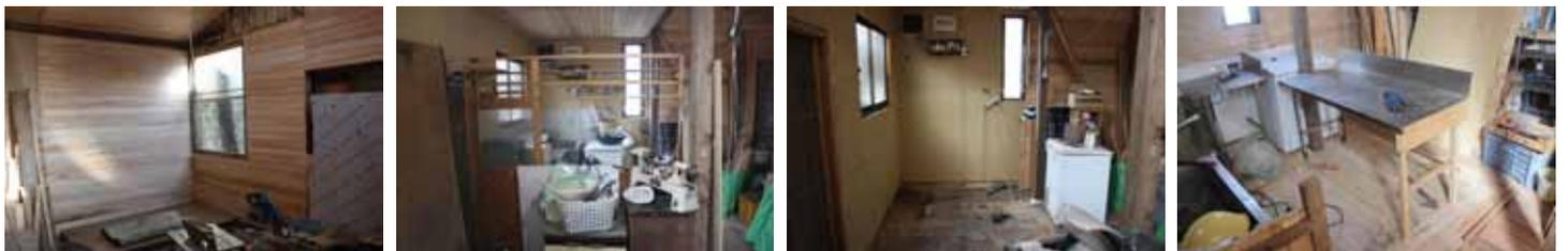
買った数万する防水壁は、飲食店のキッチン壁だったのだろう解体場から拾ってきたステン板を金槌でたたき直した。少しくらいゆがんでいても問題ない。太陽熱温水器から洗い物用に温水が出る蛇口をつけ、コンセントや照明・音響を設置していく。薪ストーブは暖と料理兼用。**設計図がなくても、コンセプトがしっかりしていれば自分に合ったモノに仕上がる。設計図の通りに完璧に作る技術より、ゆがんでいても作りながらわき出るアイデアをカタチにしていけるしなやかな頭と技術の方が好きだ。**椅子や机も「日々の掃除のしやすさを考えて軽く、背もたれのある椅子」を目指して、「設置場所とある材料を見合わせながら」1つ1つ作っていく。
